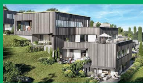
Aadorf (Ettenhausen), Terrassenhäuser «In den Reben» 4½ und 5½ Zimmer, ab Frühjahr 2026
