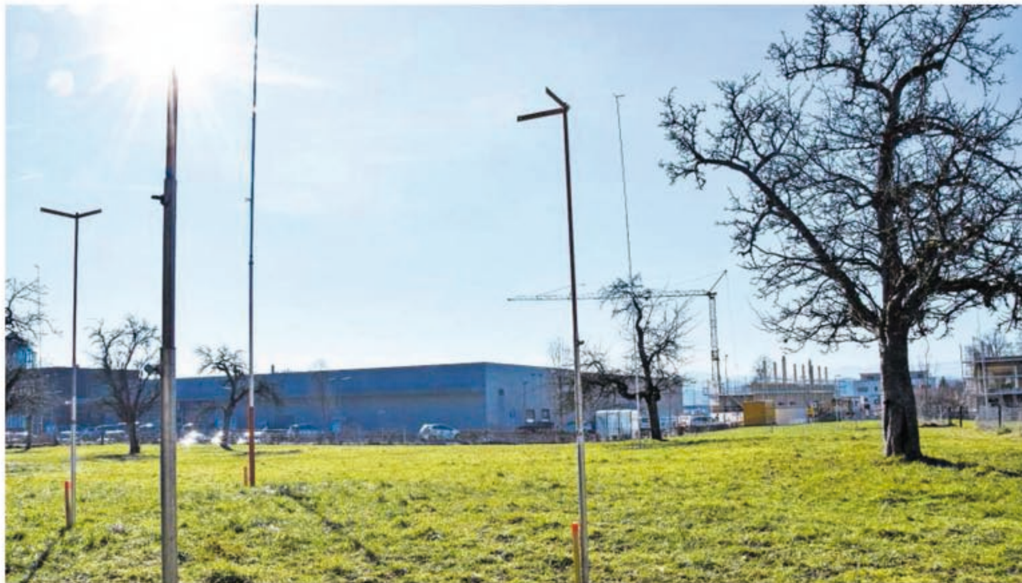
Die Visiere zeigen den Standort und die Dimensionen der geplanten Mehrfamilienhäuser an.
