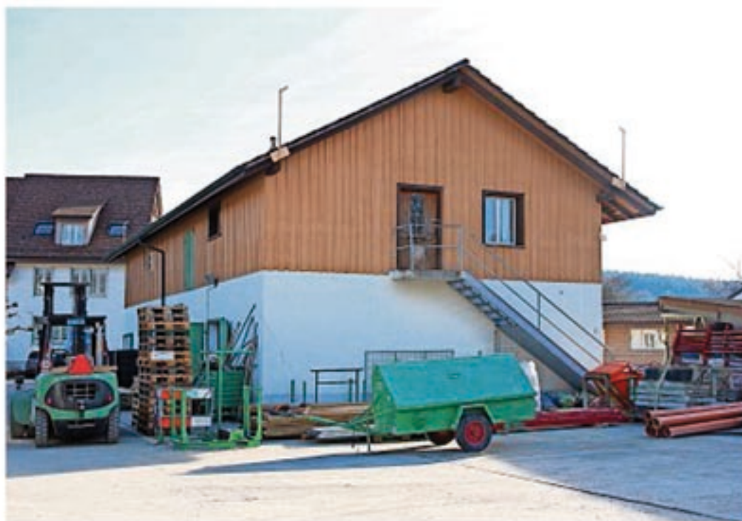
Auch dieses Magazin wird in naher Zukunft abgerissen. Hier entstehen Aufenthaltsräume für Mitarbeitende und diverse Bürolokale.
