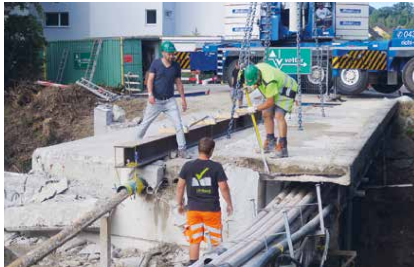
Die Entfernung des dritten und schwersten Teilstückes bereitete einige Schwierigkeiten.
